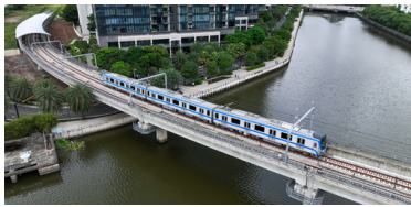
Tuyến metro số 1
